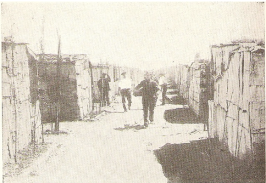
Las rudimentarias viviendas del campamento.
