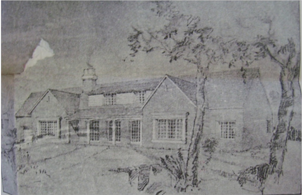
Chalet en construcción en el Barrio PParque Golden Park, 1949.
